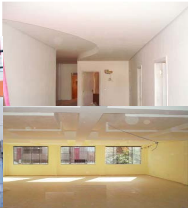
Em sentido horário: fachada, recepção e auditório em fase de acabamento.
